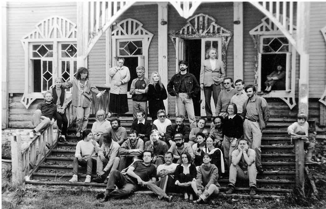
На крыльце Голубого дома. 1994 г.
